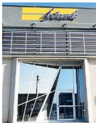
A Capriolo. L'esterno di Interseals
